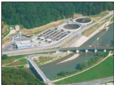
Pogled na Čistilno napravo Celje
